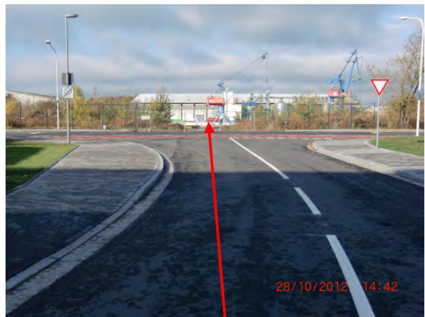
Die Hafeneinfahrt mit Zaun wird nie genutzt
