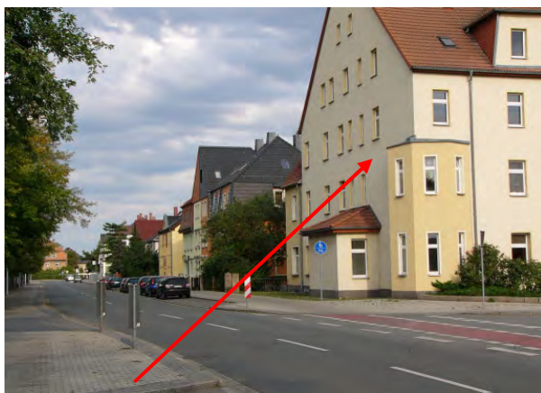
saniertes Eckhaus vor dem Abriss 2008
